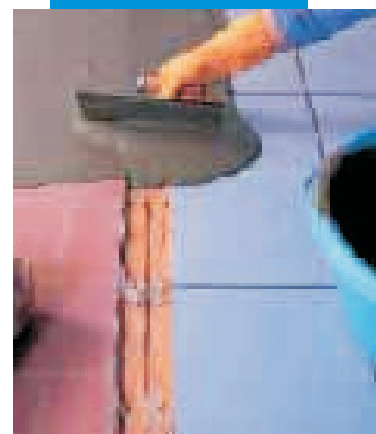
Vyrovňování povrchu staré podlahy pomocí Adesilexu P4
