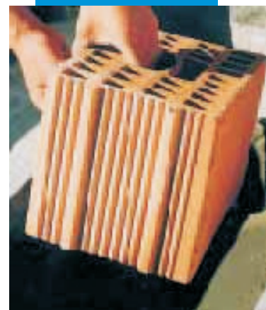
Vložení cihelného bloku do Adesilexu P4
