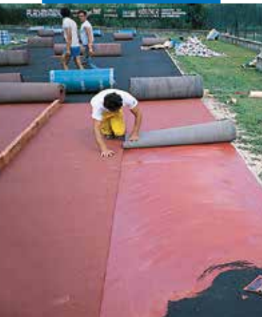
Pokládka gumové sportovní krytiny s použitím Adesilexu G19
