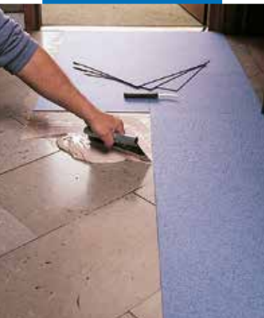
Pokládka PVC na nesavý podklad s použitím Adesilexu G19
