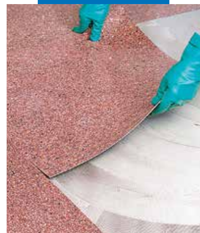
Pokládka PVC s použitím Adesilexu G19
