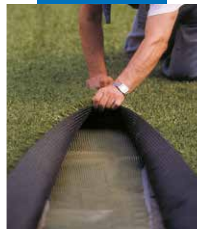
Pokládka syntetického trávníku s použitím Adesilexu G19 - Stadion San Siro - Miláno - Itálie
