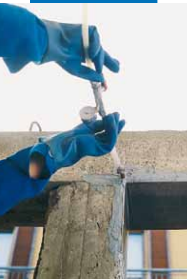
Konstrukce opravená Adesilexem PG1
